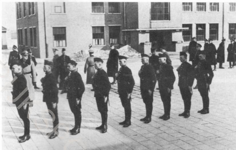
Inspectie op Schalkhaar.
