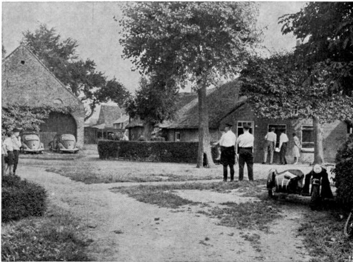
De situatie bij de boerderij van de gebroeders Van Zelst tijdens het onderzoek.
